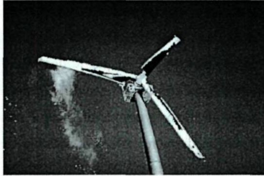
Figure 28. Une turbine éolienne givrée. Source : John Maissan, 2001
