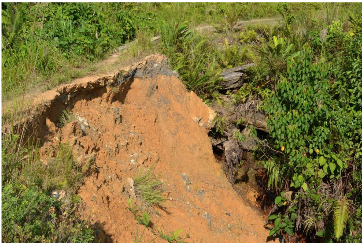
Figure 2.10. L'un des multiples glissements de terrain que nous avons observés le long du principal chemin d'exploitation forestière (photo prise en Juin 2012)
