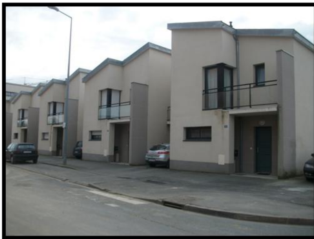
Photo 56 Logements mitoyens construits lors de l'ORU de Verneau, Rue Henri Pelauau. Auteur : Durst M.
