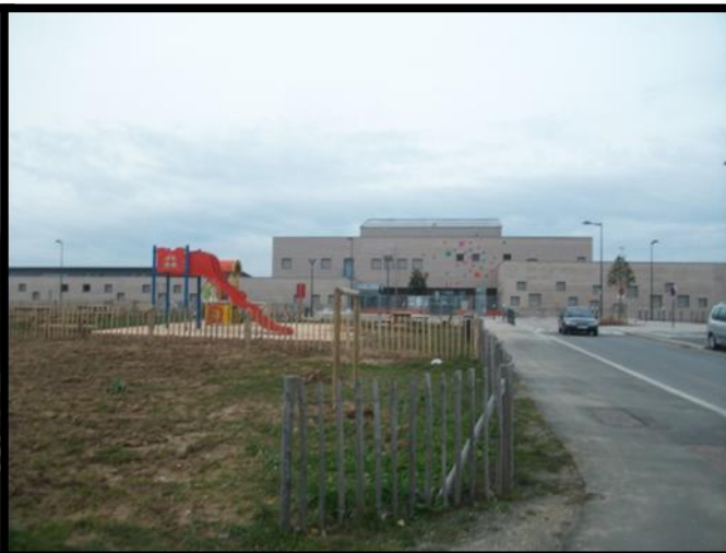
Photo 62 Nouvelle école primaire Nelson Mandela accompagnée de sa bibliothèque, Rue Isidore Odorico. Auteur : Durst M.
