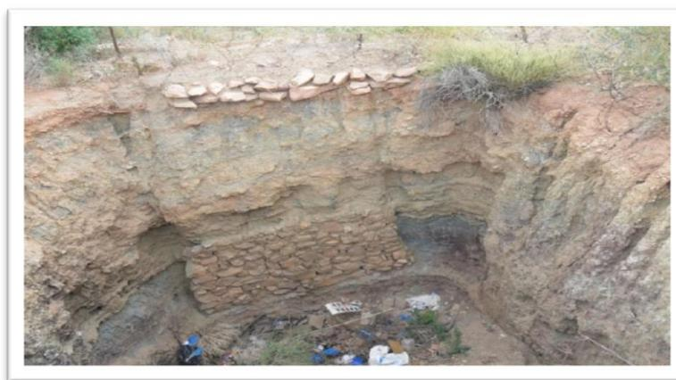
Fig. r : Affaissement d'un puits (Moghrar)
