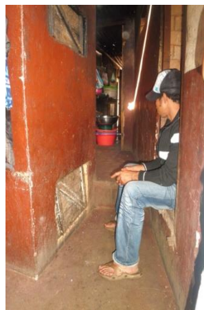
h) Ouvertures d'aération du fumoir
