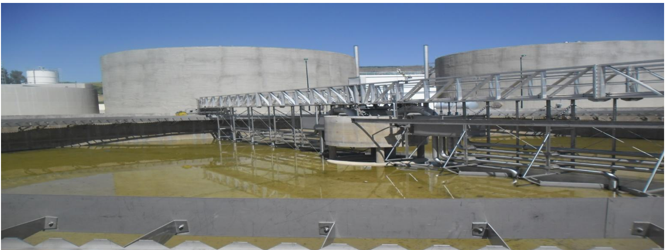
Figure 18 : Photo d'un clarificateur de la STEP de Fès
