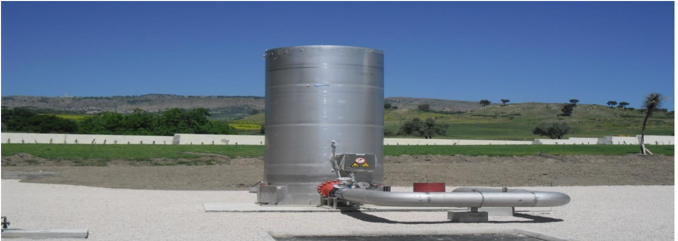
Figure 32 : Photo d'une torchère de la STEP de Fès
