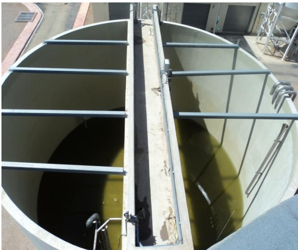
Figure 23 : Photo du bassin des boues digérée de la STEP de Fès
