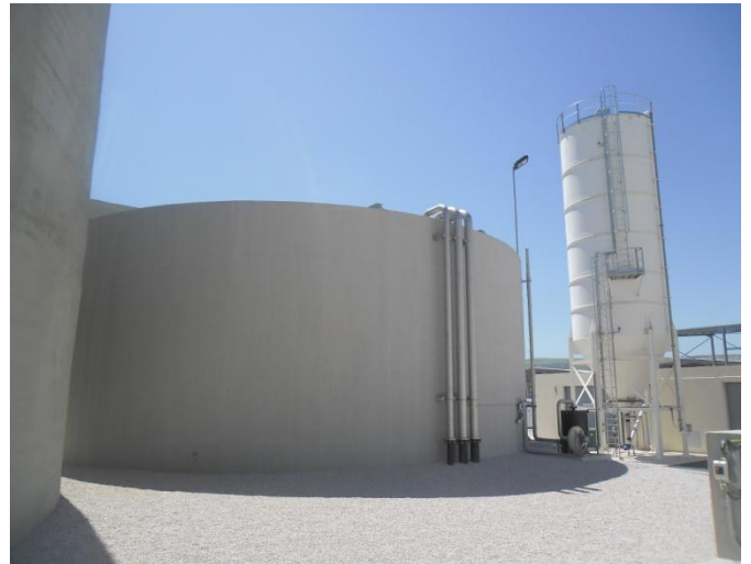
Figure 23 : Photo du bassin des boues digérée de la STEP de Fès
