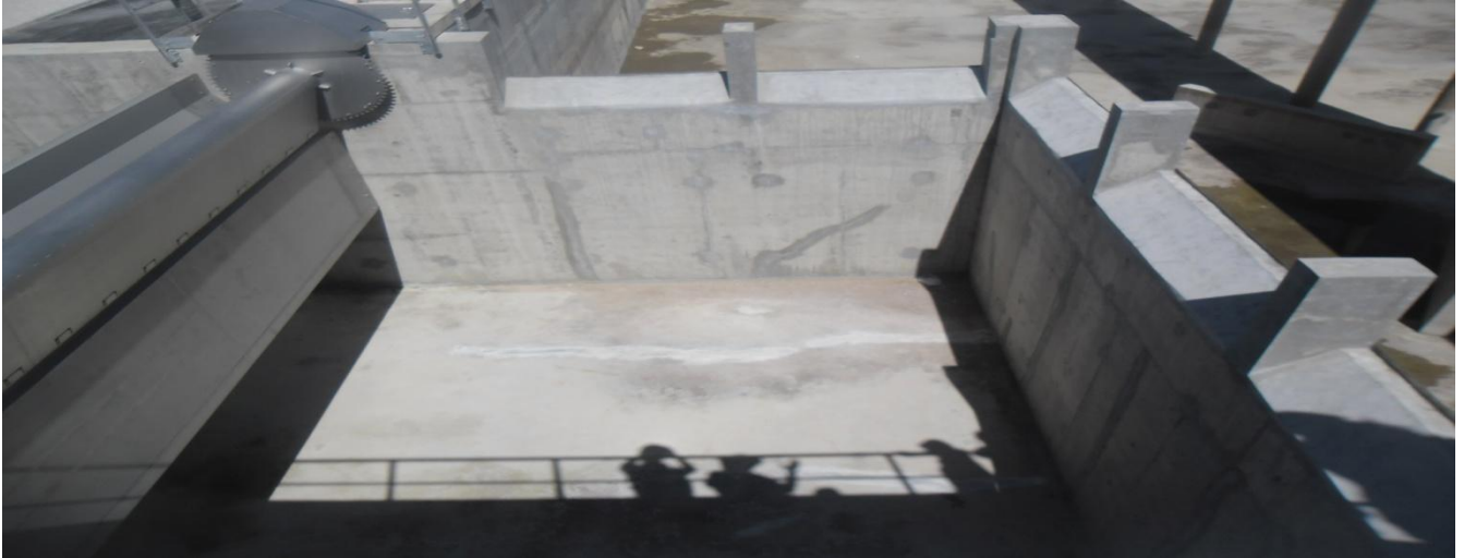
Figure 17 : Photo de la zone de dégazage de la STEP de Fès
