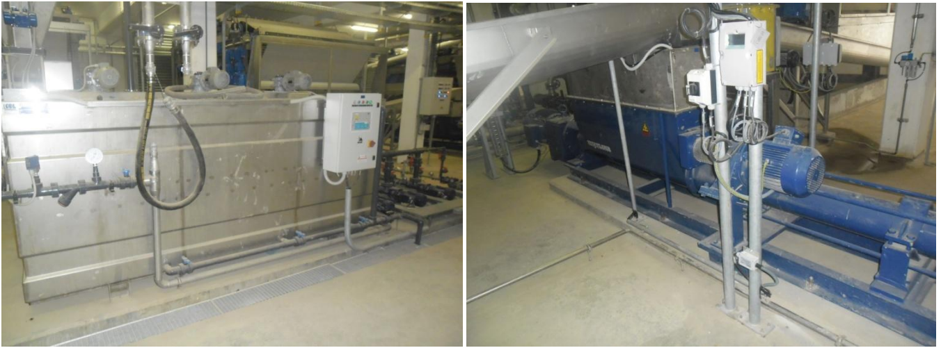
Figure 26: Unités de préparation automatique de polymère et pompe gazeuse de la STEP de Fès
