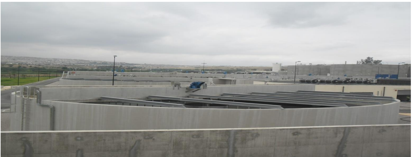
Figure 19: photo d'un épaisseur de la STEP de Fès
