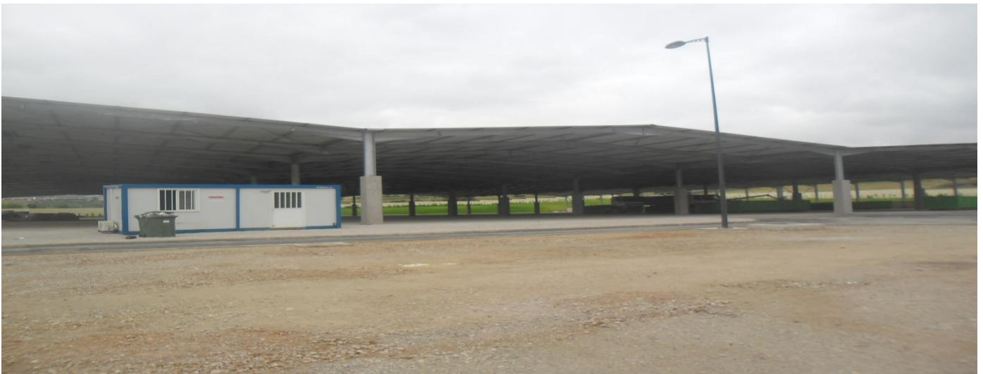
Figure 28 : Photo d'un Hall de stockage de la STEP de Fès
