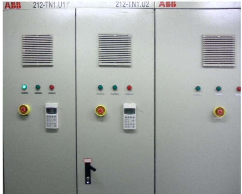
Un centre de commande de moteur comprend un ou plusieurs articles verticaux armoire métalliques avec le bus d'alimentation et un montage de contrôleurs de moteur individuels (puissance + commande). Chaque contrôleur de moteur contient un contacteur, un relais de surcharge pour protéger le moteur, des fusibles ou un disjoncteur pour éviter les courts-circuits, des variateurs de fréquence, des automates programmables, et un sectionneur pour isoler le circuit du moteur.
