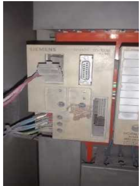
Figure 26 : le CPU 103U du SIMATIC S5
