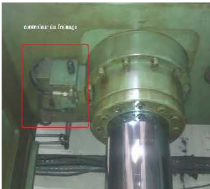
Figure 14 : contrôleur du freinage du coulisseau
