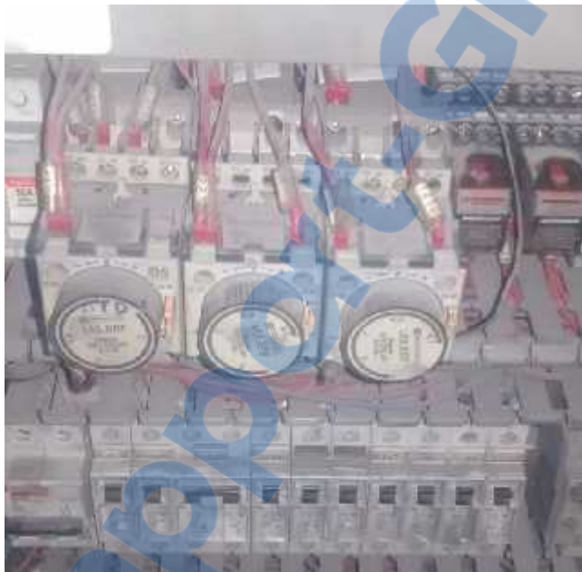
Figure 31 : les Relais temporisés OFF DELAY 0,1-3s
