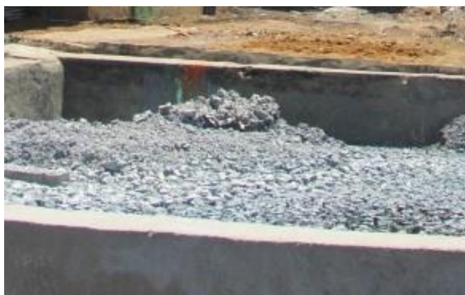
Photo 4: Stockage de boues
