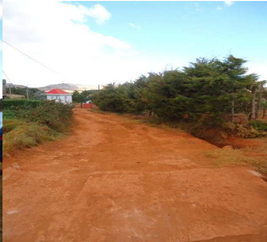
Piste d'accès vers le Station
