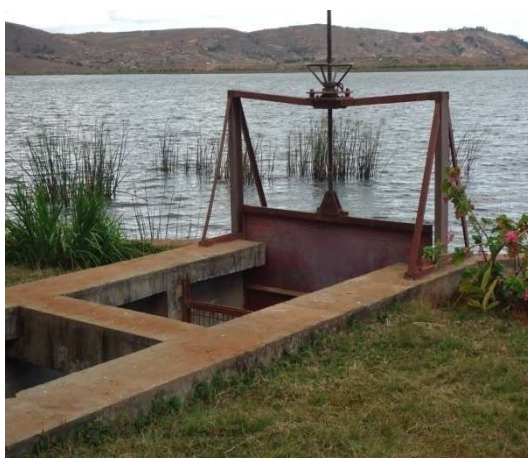
Ouvrage de captage
