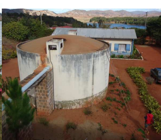
bâtiment d'exploitation, bâche
