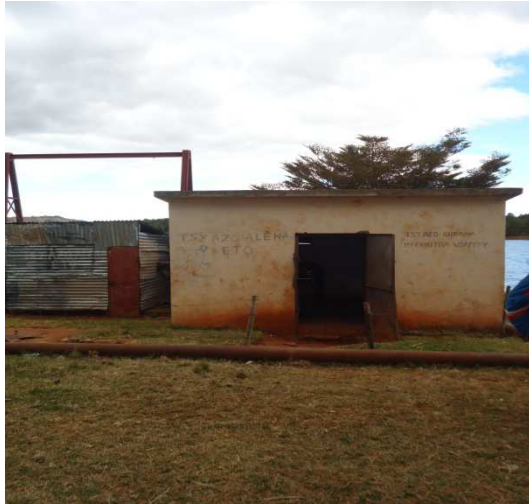
Cabinet de captage : besoin de clôture
