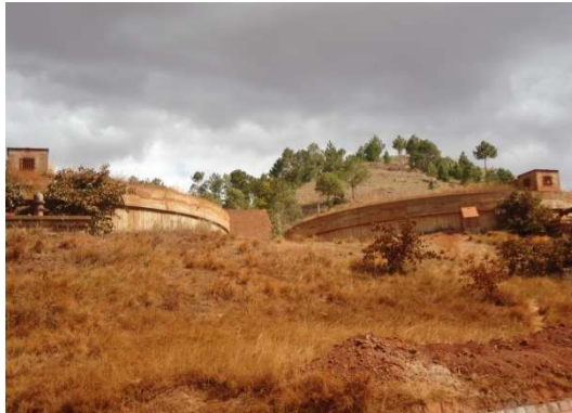
Réservoir non opérationnel
