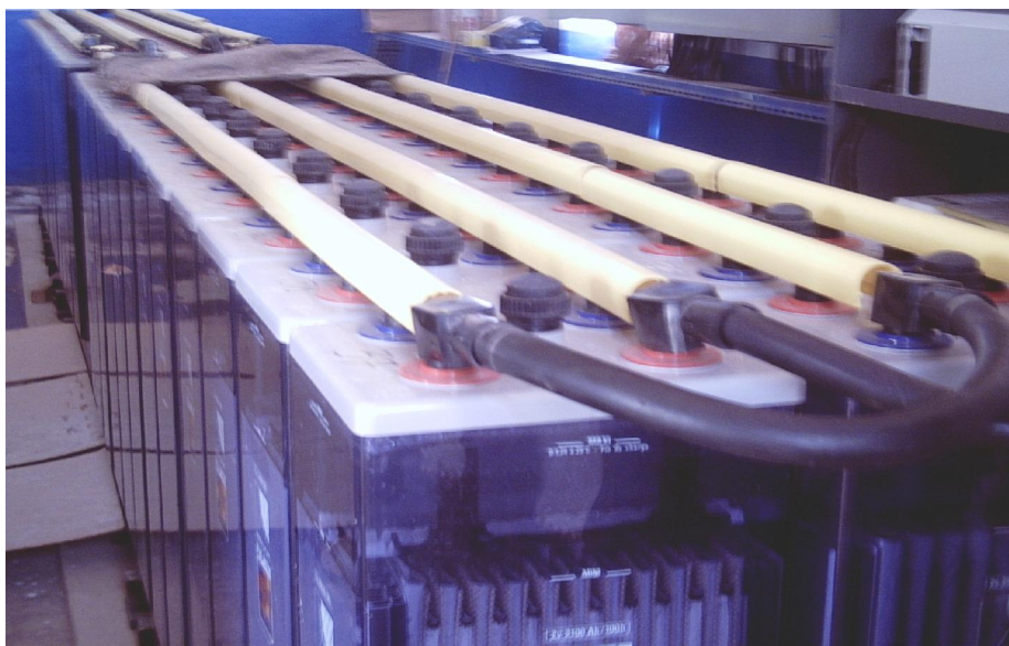
Figure N° 26 : Le parc à batteries de la centrale
