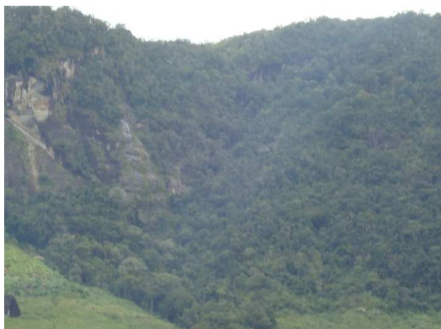
Photo 4 : Aperçu du corridor dans la commune
