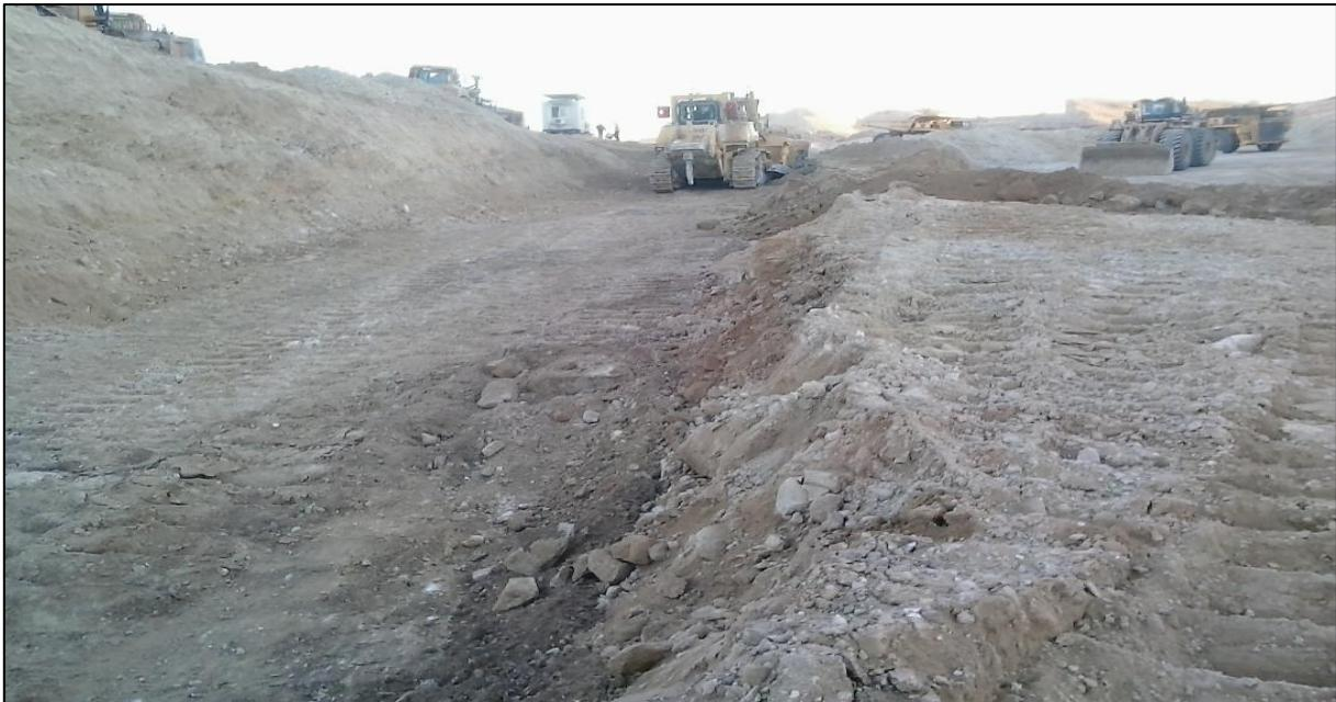
**Photo 27 : Exemple d'un chargement contre déblai**
