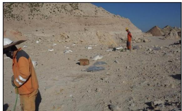
photo 7 : Remplissage des puits par l'Ammonix
