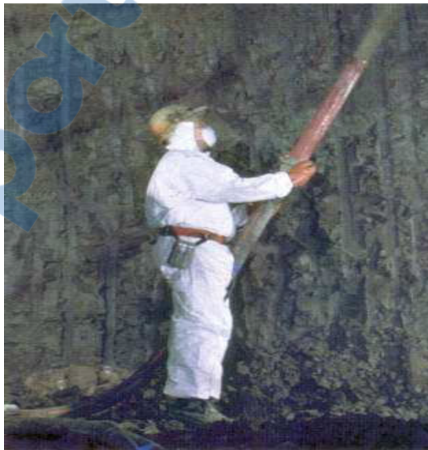
Figure II.16 : Projection par voie sèche [1].
