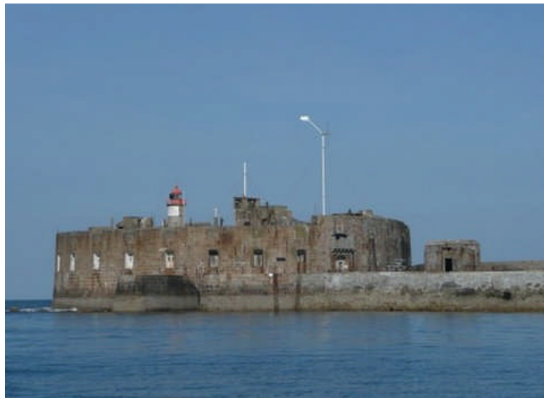
Photo 1 : ouvrages implantés en site maritime [1].
