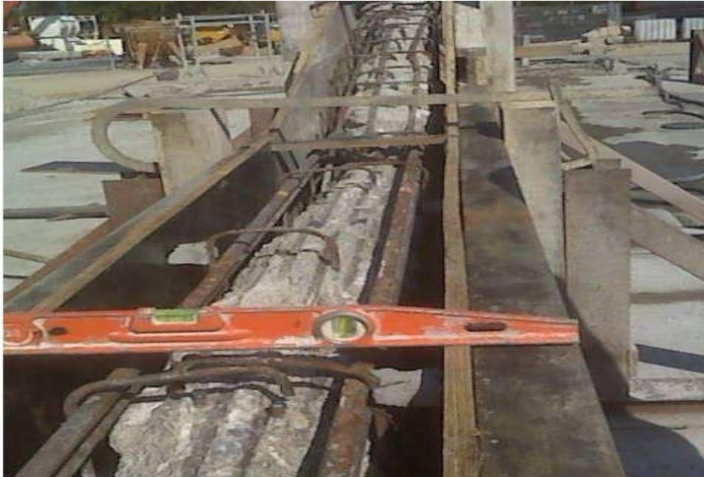
Figure II.18 : Projection par béton coffré [GRO 2001].
