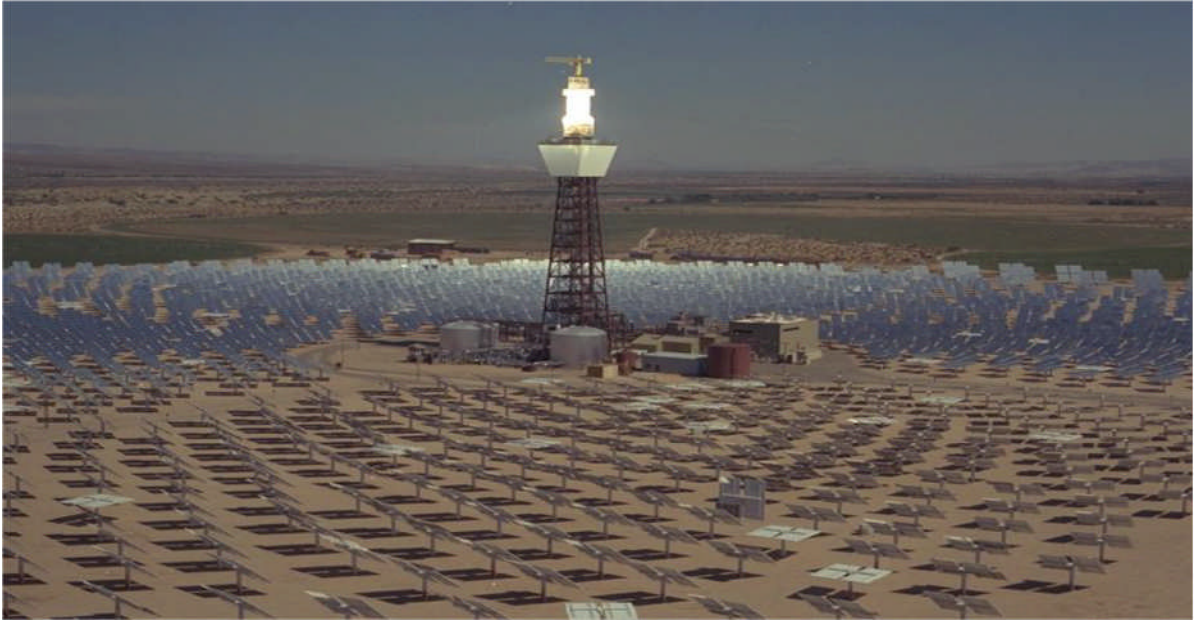
Figure II.2 : centrales solaires à tour
