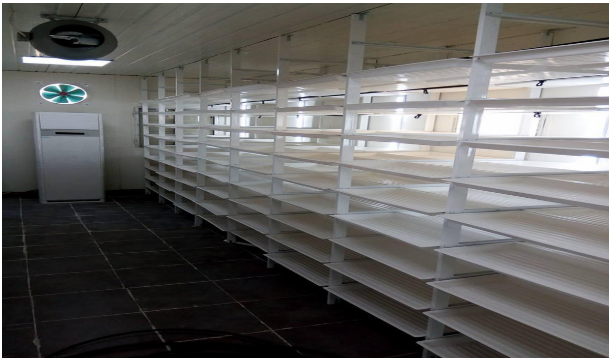
Figure 72 : La mise en place du système
