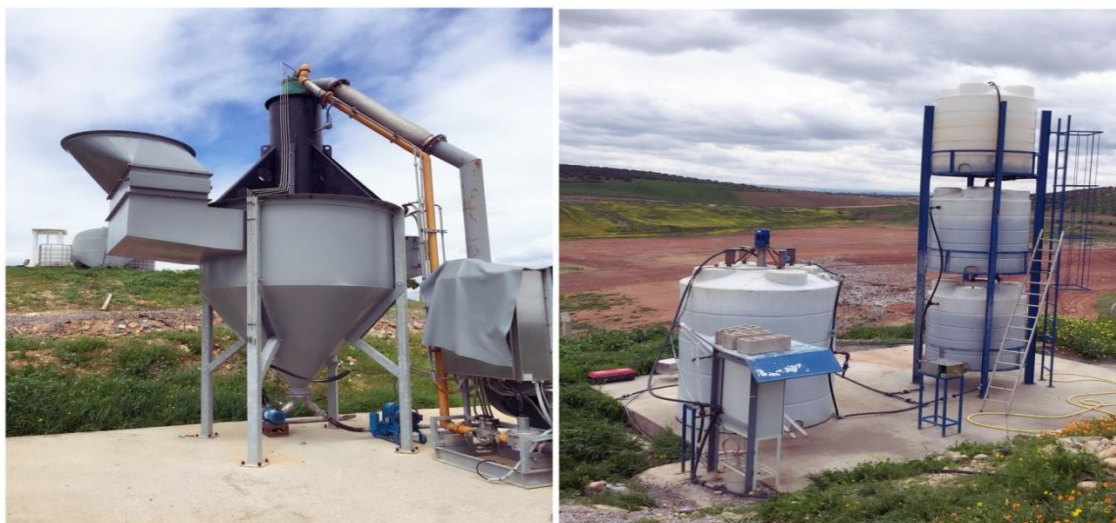
Figure 23: De gauche à droite, l'évaporateur thermique, filtration par membrane biologique
