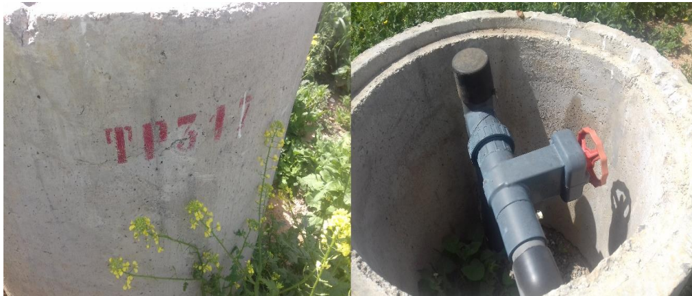
Figure 12: Tête de puits
