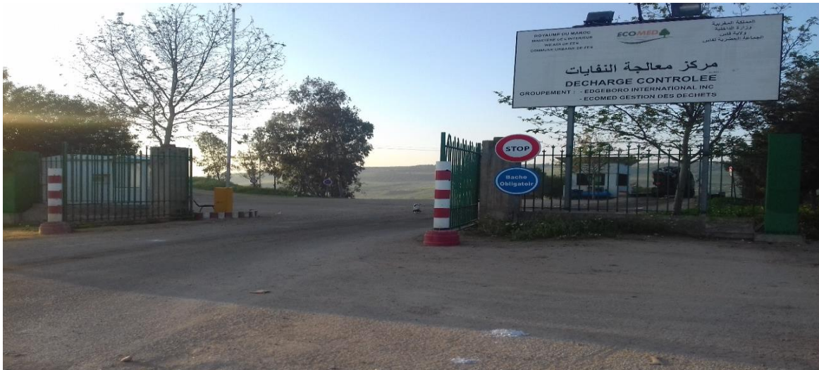
Figure 6: La décharge contrôlée de FES
