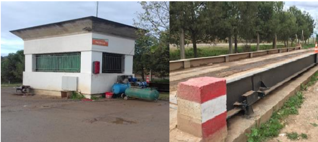
Figure 7: La salle de pesage avec le pont-bascule
