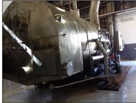
Figure 7: Chaudière de capacité 13 bar
