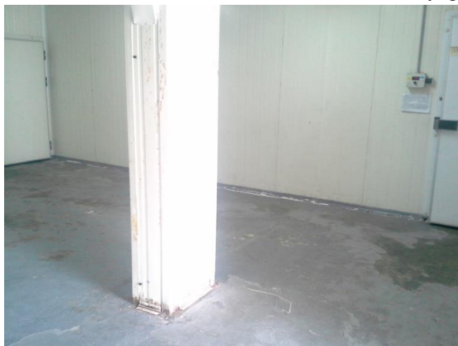
Figure 37: L'état de la zone après le nettoyage
