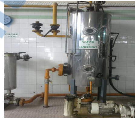
Figure 10 : Bac de lancement
