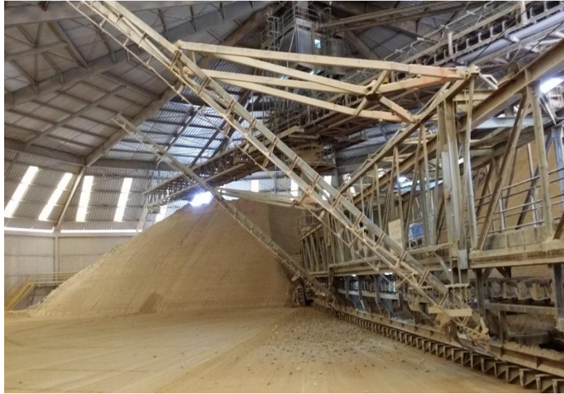
Figure 4 : hall de la préhomogénéisation
