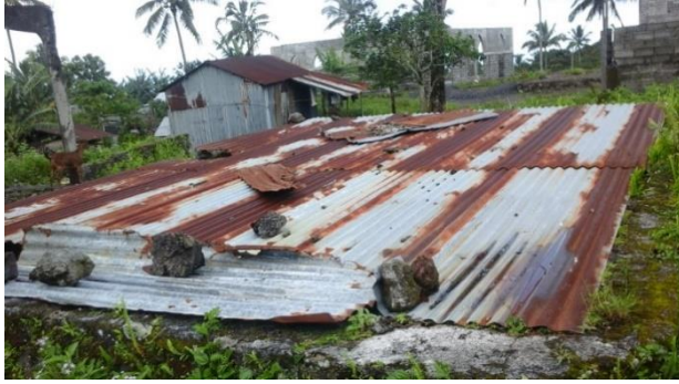
Photographie 27 : Citerne couverte de tôles à Famaré à la Grande Comore
