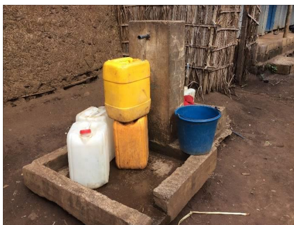
Photographie 25 : robinet public dans le village de Nounga à Anjouan
