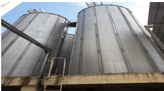
Photo des silos de stockage
