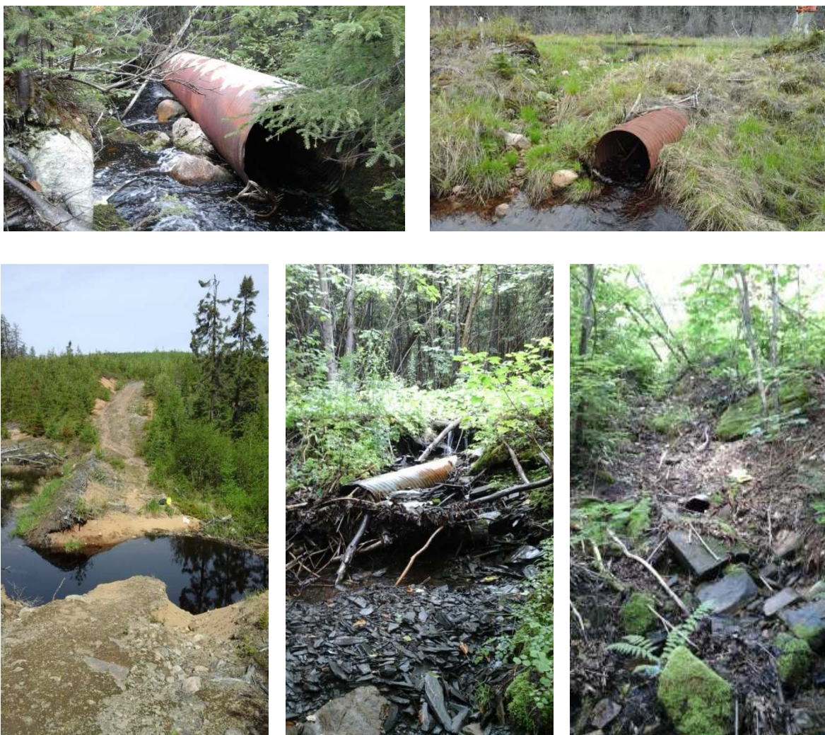
Figure 17 – Traverses en TTOG dans un état non fonctionnel retrouvées dans les secteurs d'étude
