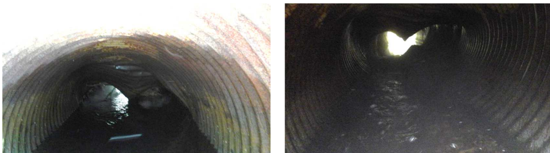
Figure 16 – Exemple de traverses en TTOG dans l'état critique âgées de moins de 25 ans
