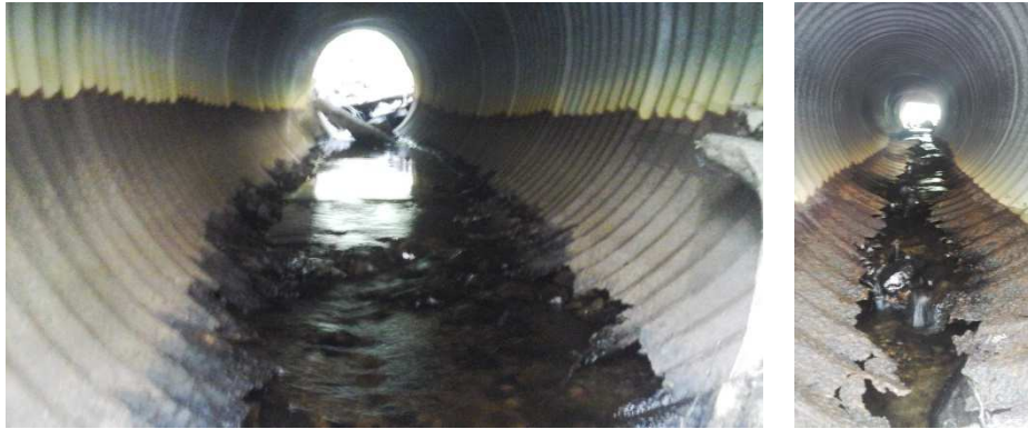
Figure 15 – Exemple de traverses en TTOG dans l'état critique de plus de 35 ans
