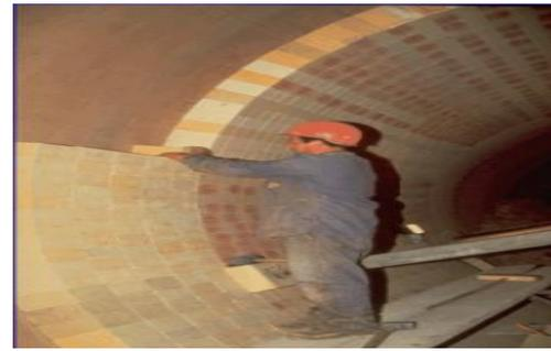
**Figure 7 :** Installation des briques réfractaire
