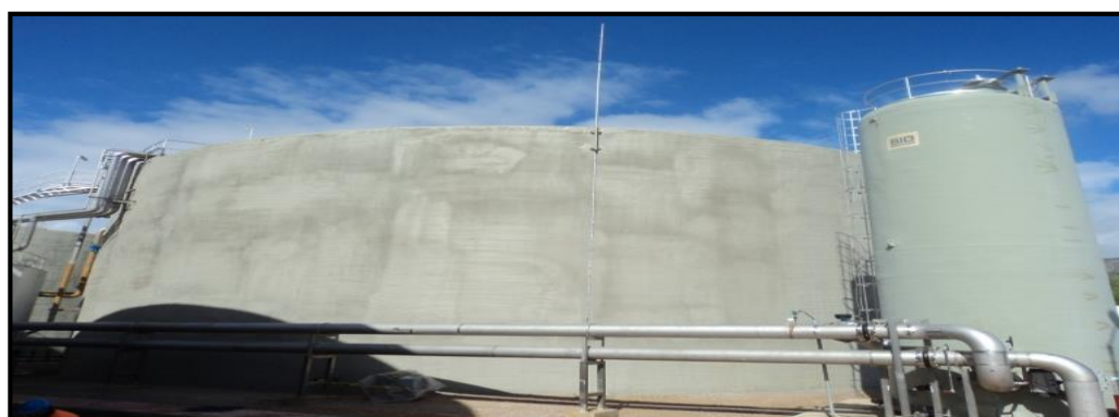
FIGURE 1.8 : DIGESTEUR STEP FES
