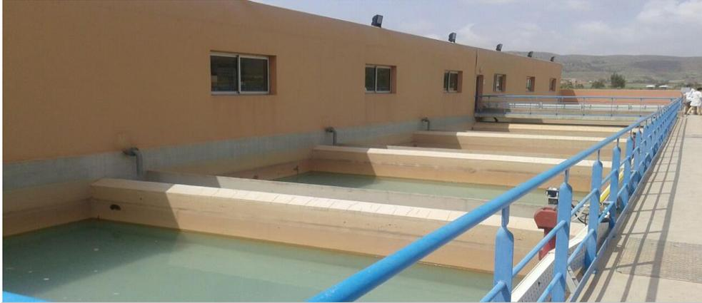
**Figure 4 : Les filtres à sable**
