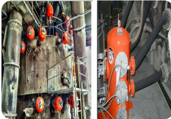
**Figure 31 : Position des Airhocs sur un cyclone**
