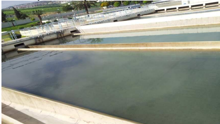
Figure 6 : Filtre à sable
