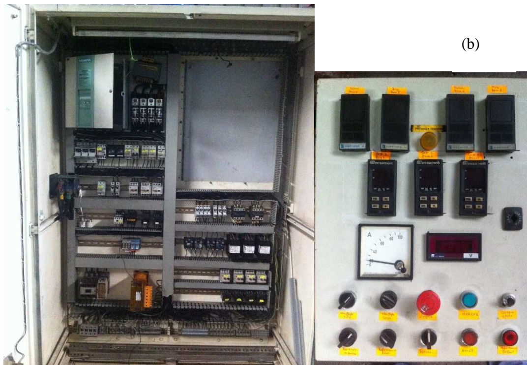
Figure 31 : l'armoire électrique (a) et le coffret de commande (b) Pour le câblage des éléments l'électricien respectera les schémas déjà préétablis.
