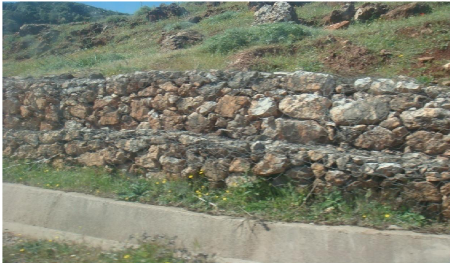
Figure 25 : Technique de soutènement "mur en maçonnerie"
