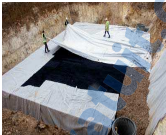
Photo 9. Recouvrement des blocs[5]
