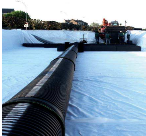
Photo 7. Installation du drain de diffusion[5]
