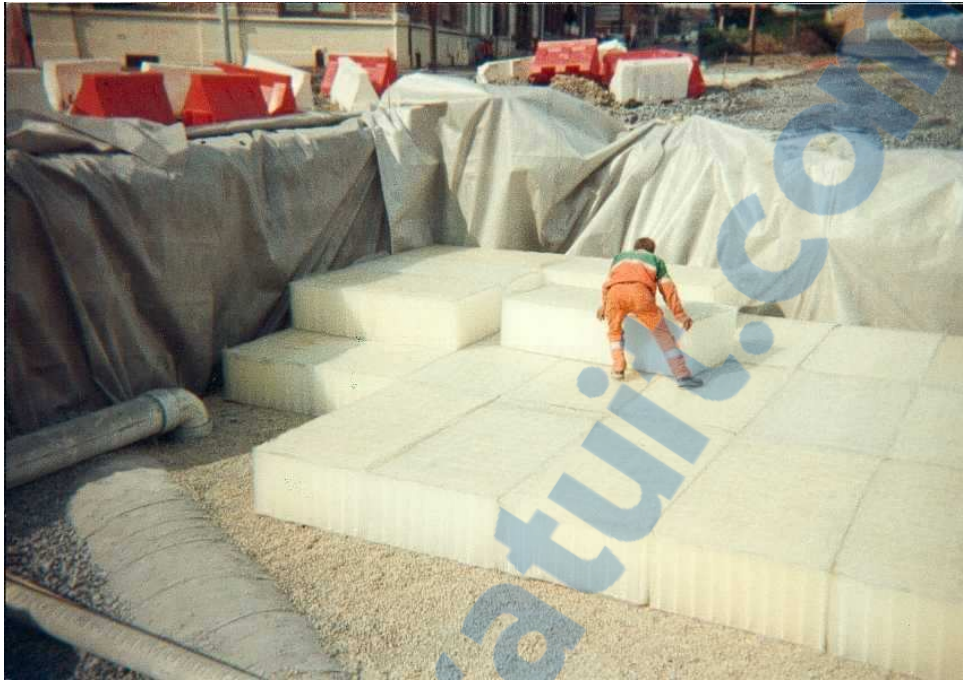
Photo 3. Réalisation d'un bassin en structure alvéolaire ultra légère [4]
