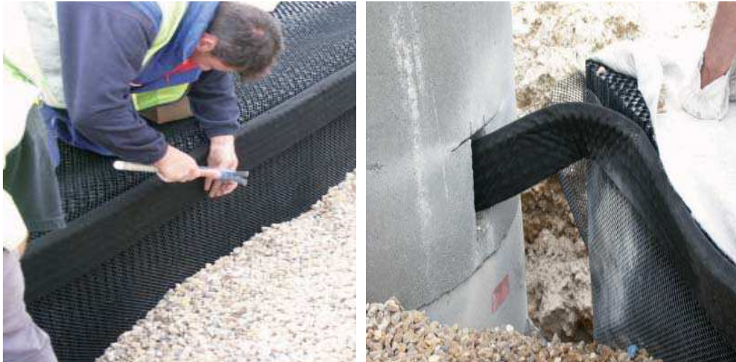
Photo 8. Installation de la couche de ventilation[5]
