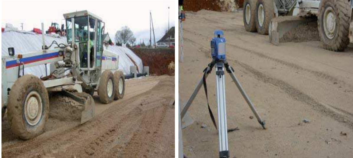
Photo 5. Nivellement du fond de la fouille [5]
