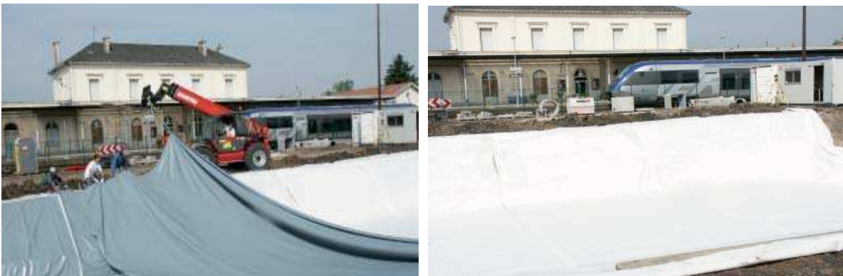
Photo 6. Réalisation de l'étanchéité du bassin de rétention [5]
