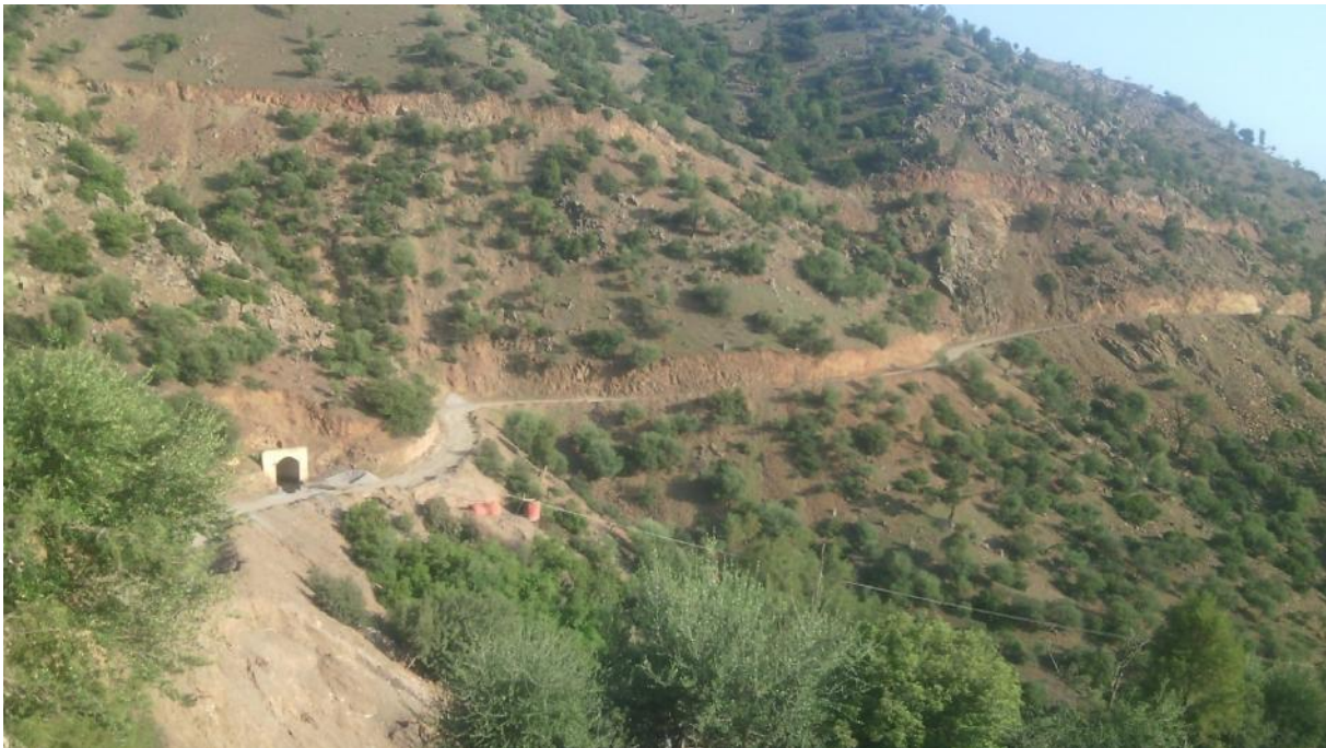
Figure 21 : photo montrant la zone de travail
