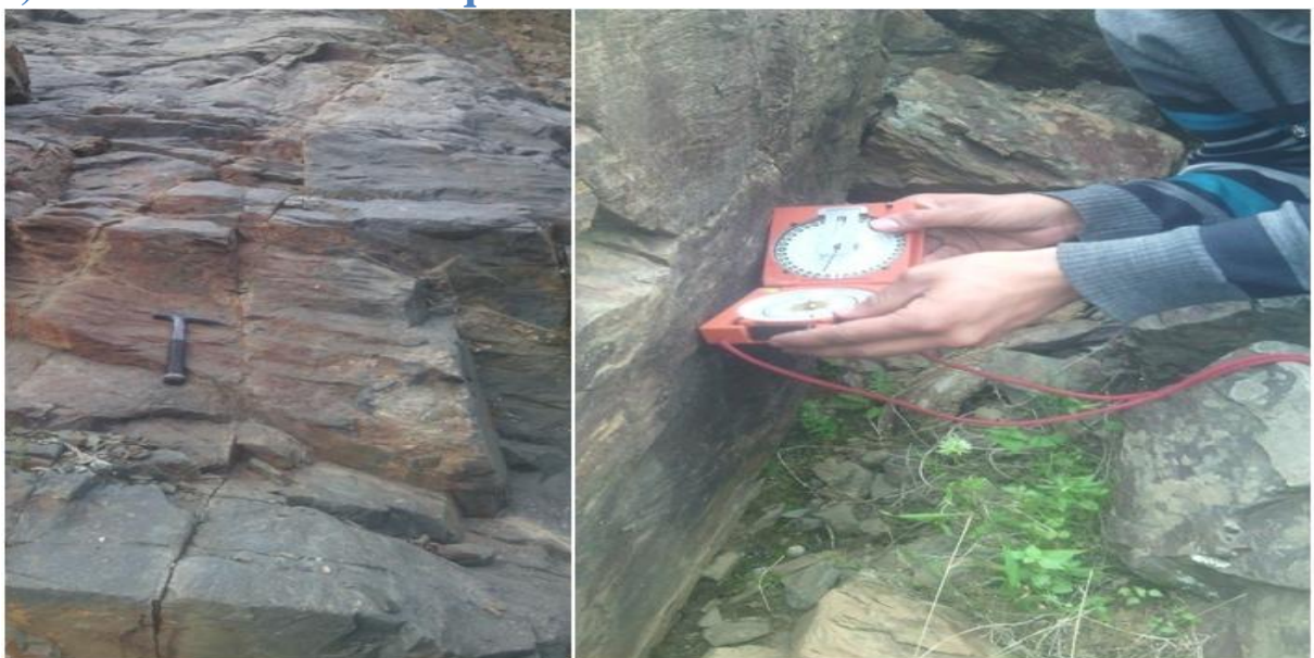
Figure 26 : photo montrant deux plan de failles
