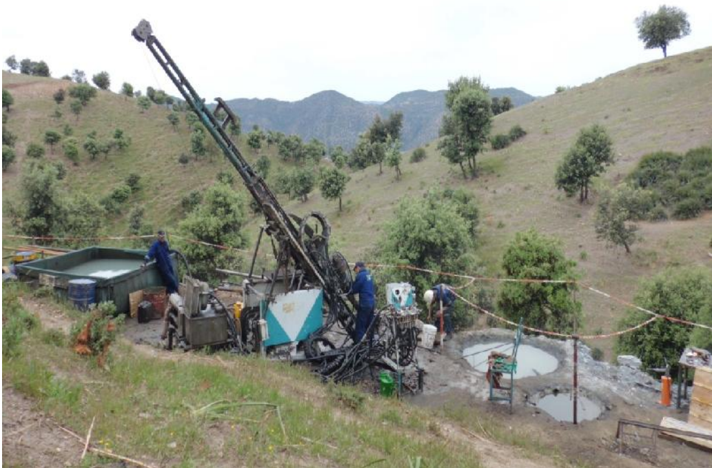
Figure 13 : machine de sondage (Sondeuse LY44)
