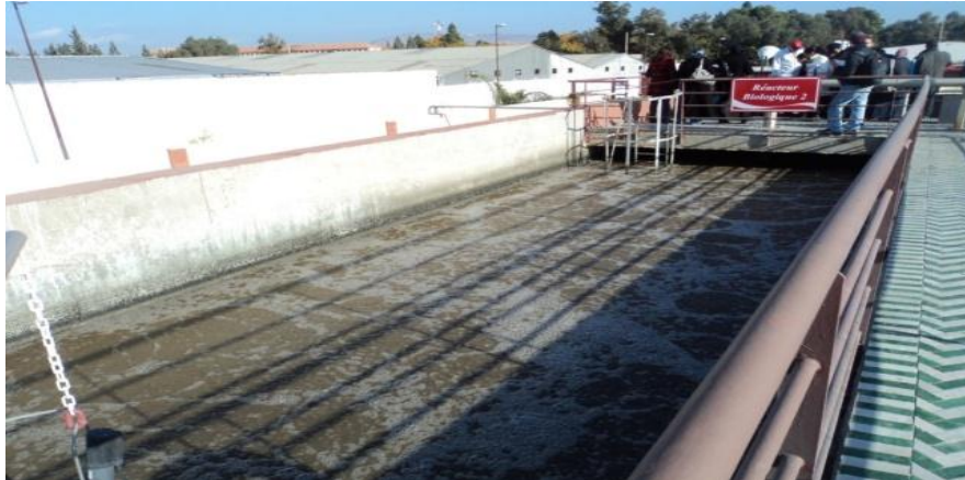
Annexe 11 : Bassin de floculation de STEP de la CBGN
