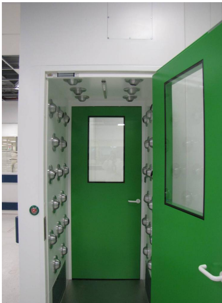
Figure 16 : douche à air
