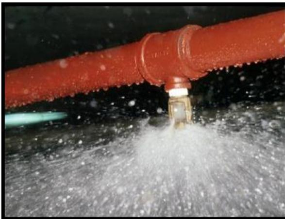
Figure 26: Sprinkler déclenché
