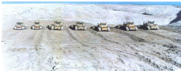
Figure5 : Décapage par Bulldozers
