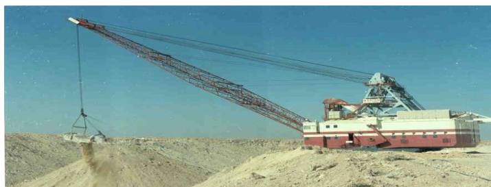
Figure6 : Décapage par Draglines
