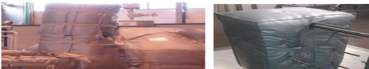
Figure 47: Exemple de calorifugeage de matelas isolent
