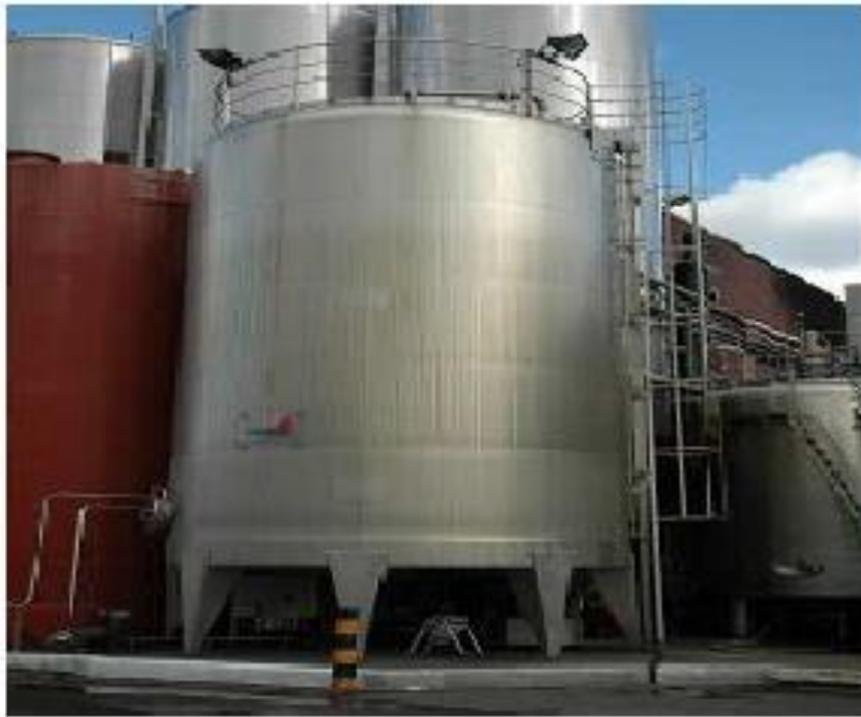
**Figure 6 : Fermenteur utilisé dans la fabrication de la levure**
