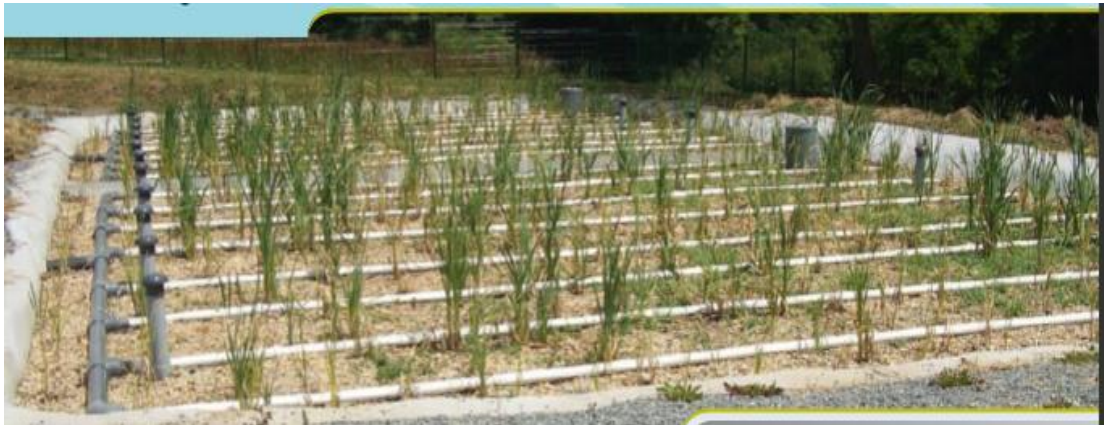
Figure 9: filtres avec les plantes de roseaux
