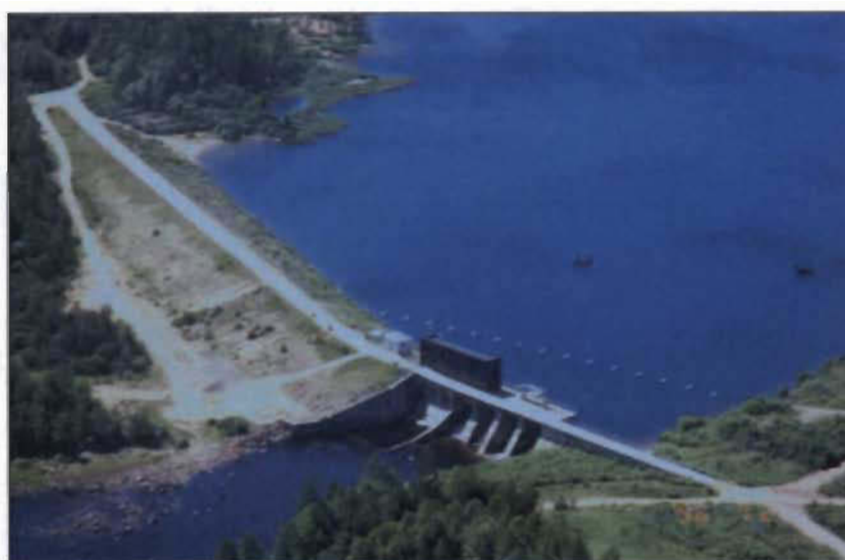
Figure 2.5 Vue aérienne du réservoir Châteauvert sur la rivière Manouane.
