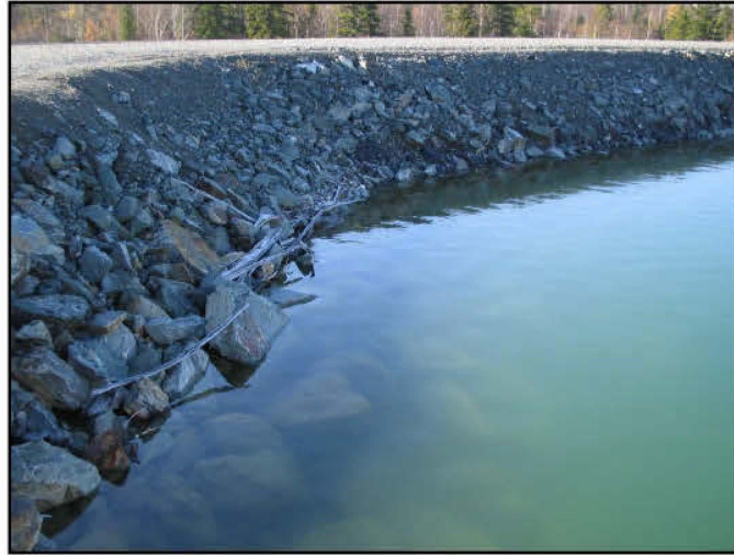
Figure B.3. Digue de parc à résidus minier servant pour un stockage subaquatique des résidus
