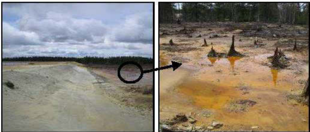
Figure C.1. Photographes d'un parc à résidu abandonné affecté par la production de drainage minier acide et de ses environs (Abitibi-Temiscamingue, Québec).
