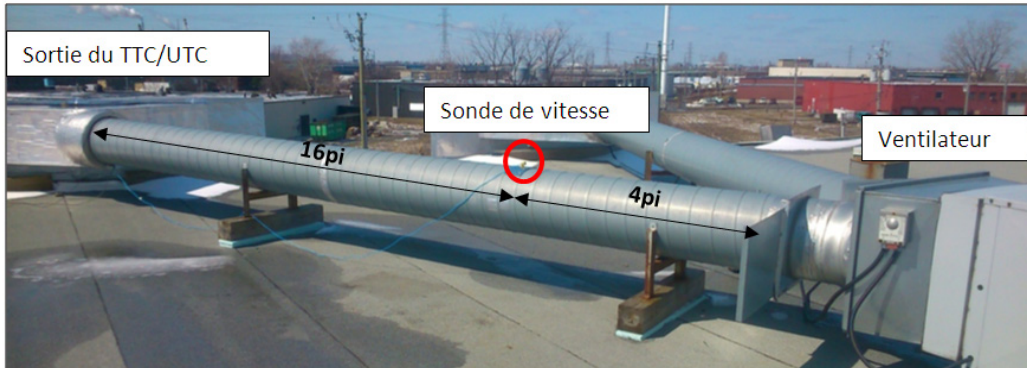
Figure 2.10 Illustration du positionnement axial de la sonde de mesure de la vitesse de l'air dans la conduite
