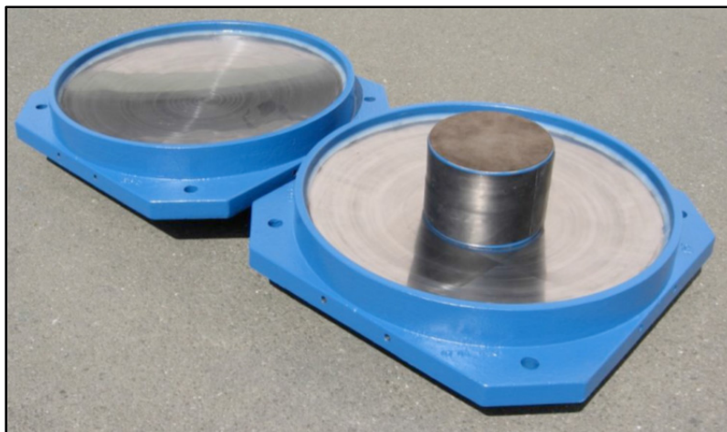
Figure 1.21 Exemple de pendule à friction Tirée de Ogorzalek et Stephen (2010)
