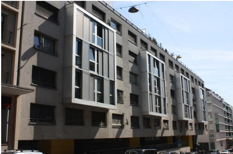
V. Perrin (2015). Exemple de rénovation du bâti à la rue Rothschild
