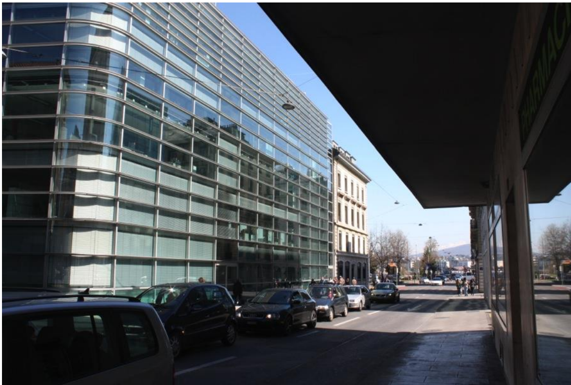
Fig. 12 : Victor Perrin (2015). Le bâtiment en verre de la SGS sur la rue des Alpes
