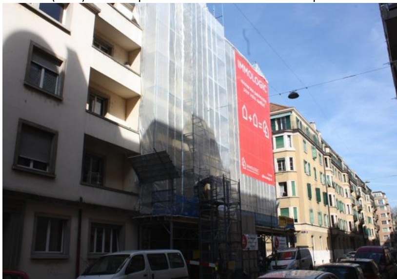
Victor Perrin (2015). Opération de rénovation du bâti à la rue Jean-Jacquet
