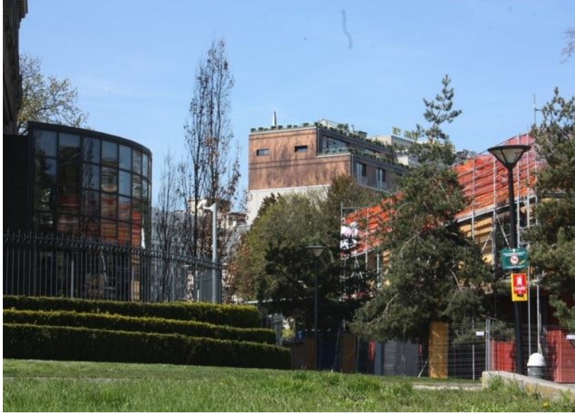
V. Perrin (2015). Travaux publics et rénovations à la rue Butini, près du Wilson
