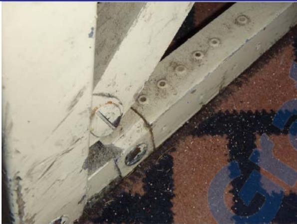
Figure 6 Pertes de revêtement de l'ossature en métal
