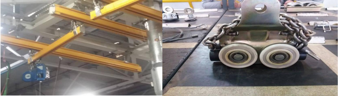
Figure 50 : Système de guidage de la pince
