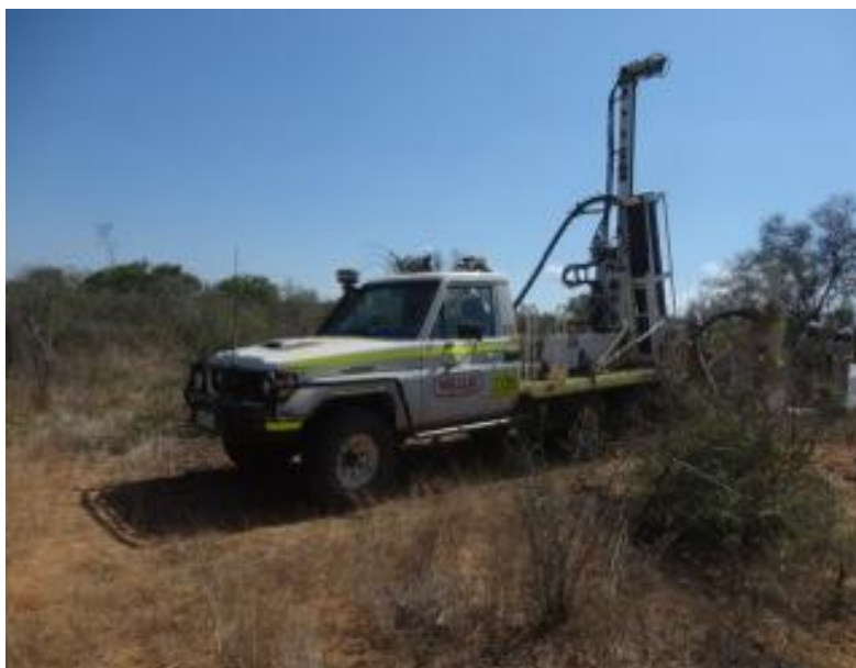
Photo 11: La machine sondeuse porté par un véhicule 4X4, utilisée pendant la campagne de forage 2012, source : Toliara Sands
