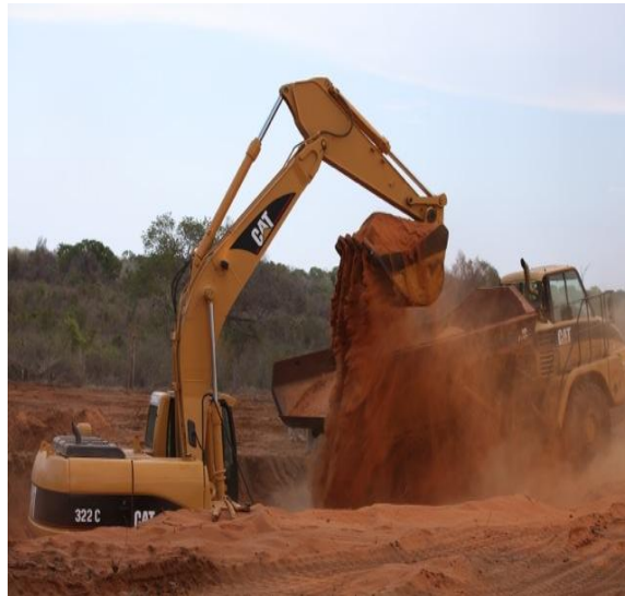
Photo 15 : Les matériels utilisés pendant l'extraction en masse 2012, source : Toliara sands
