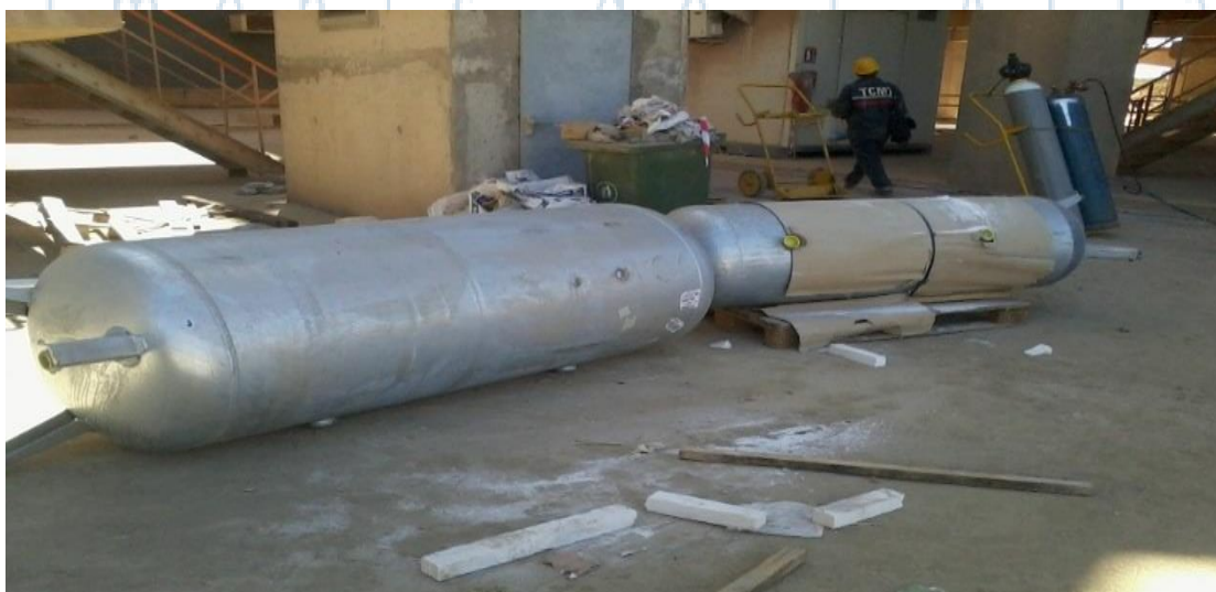
Figure 99: Ballon d'air de volume 500L et 1000L
