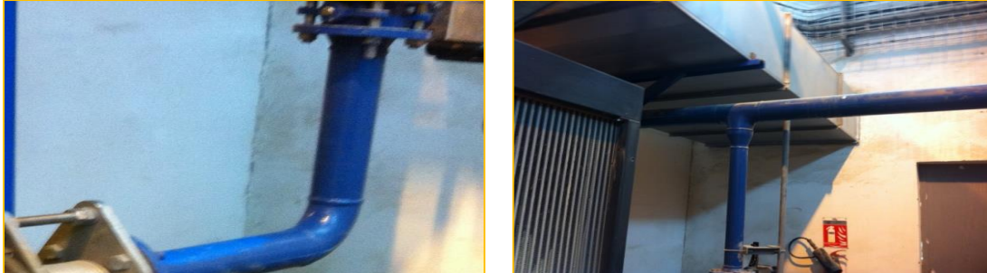
Figure 59: Absence d'un purgeur et la conduite reliée par le bas
