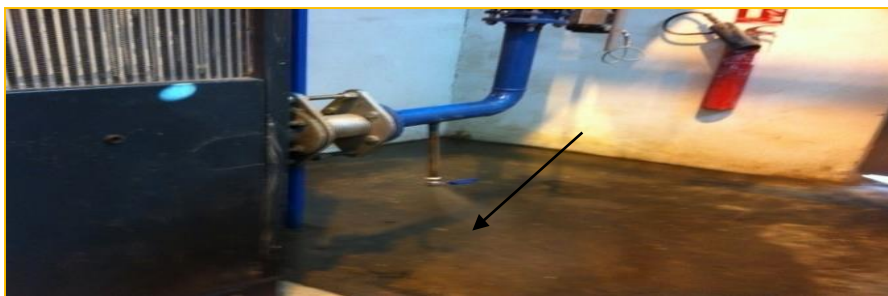
Figure 89: Présence d'eau dans le circuit après avoir installé un purgeur
