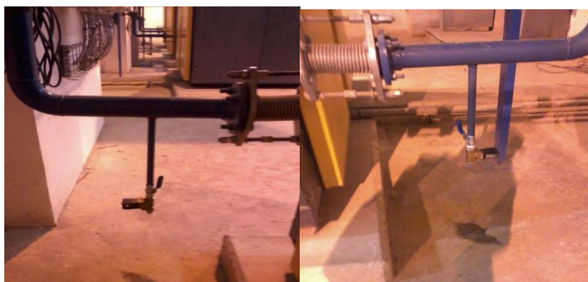
Figure 91: Purgeurs installés pour les quatre compresseurs
