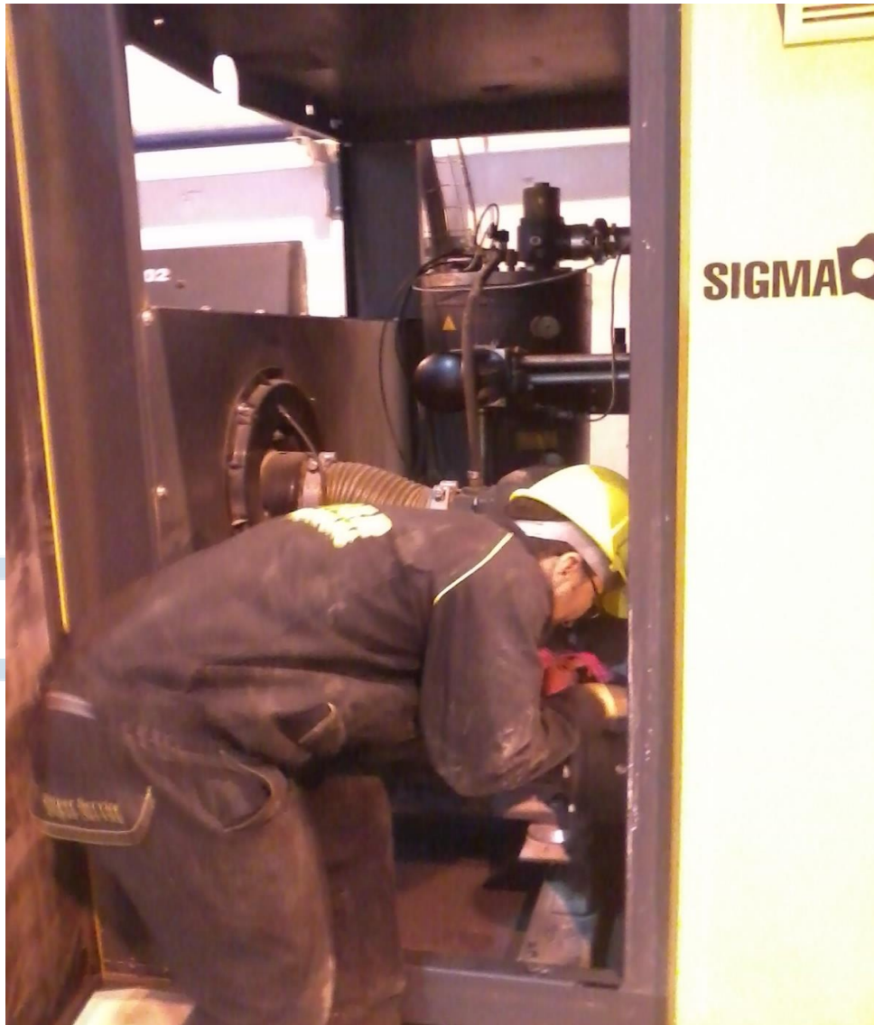
Figure 54: Maintenance des compresseurs
