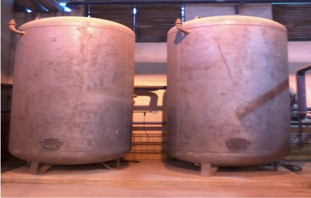
Figure 29: Les ballons d'air
