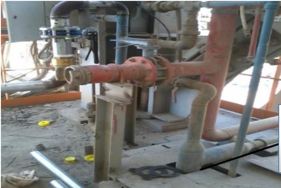
Figure 102: La liaison entre la salle des compresseurs et le ballon installé
