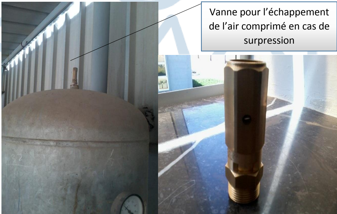
Figure 101: L'ajout de la vanne de réglage de pression ( P_{max}=12bar )
