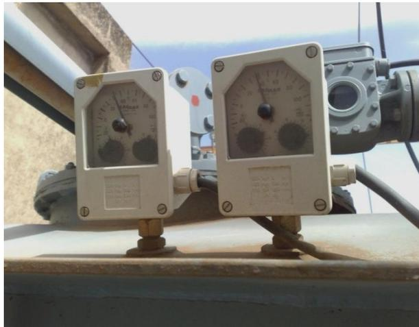
**Fig. 6 : Dispositif de détection de température**
