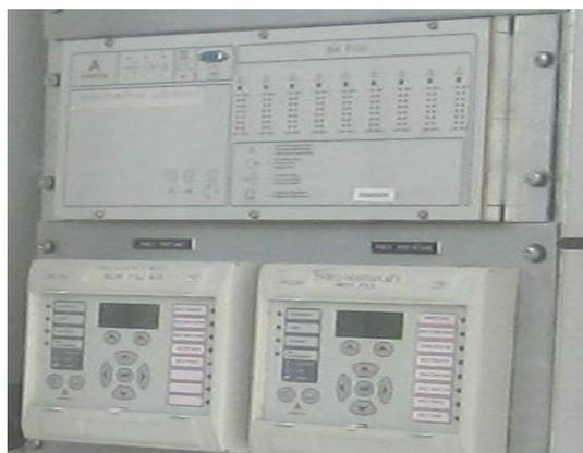
**Fig. 13 : Relais ampérométrique type numérique**
